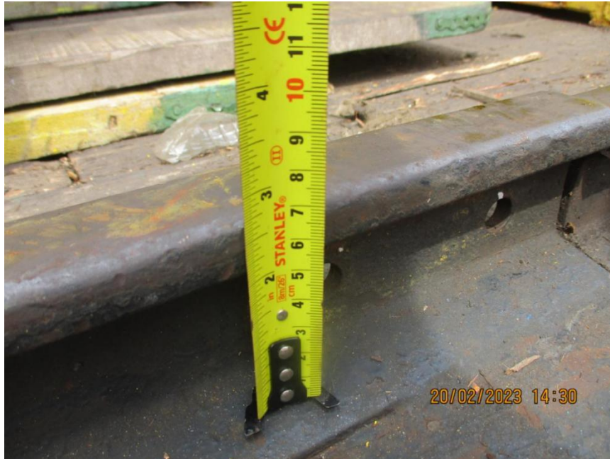
Fig: A-Frame railing height
